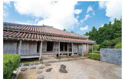
沖縄県の伝統的な家屋(久米島)
